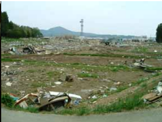
階上地区の被害
