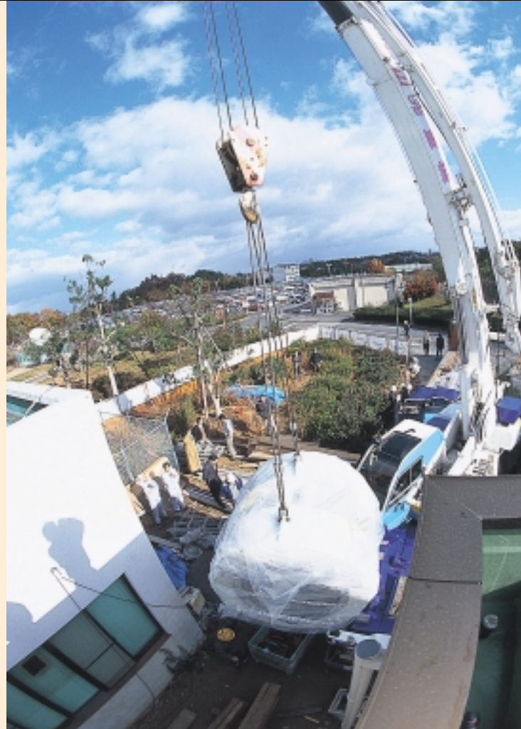
12月3日に行なわれた MRシステムの設置工事風景
